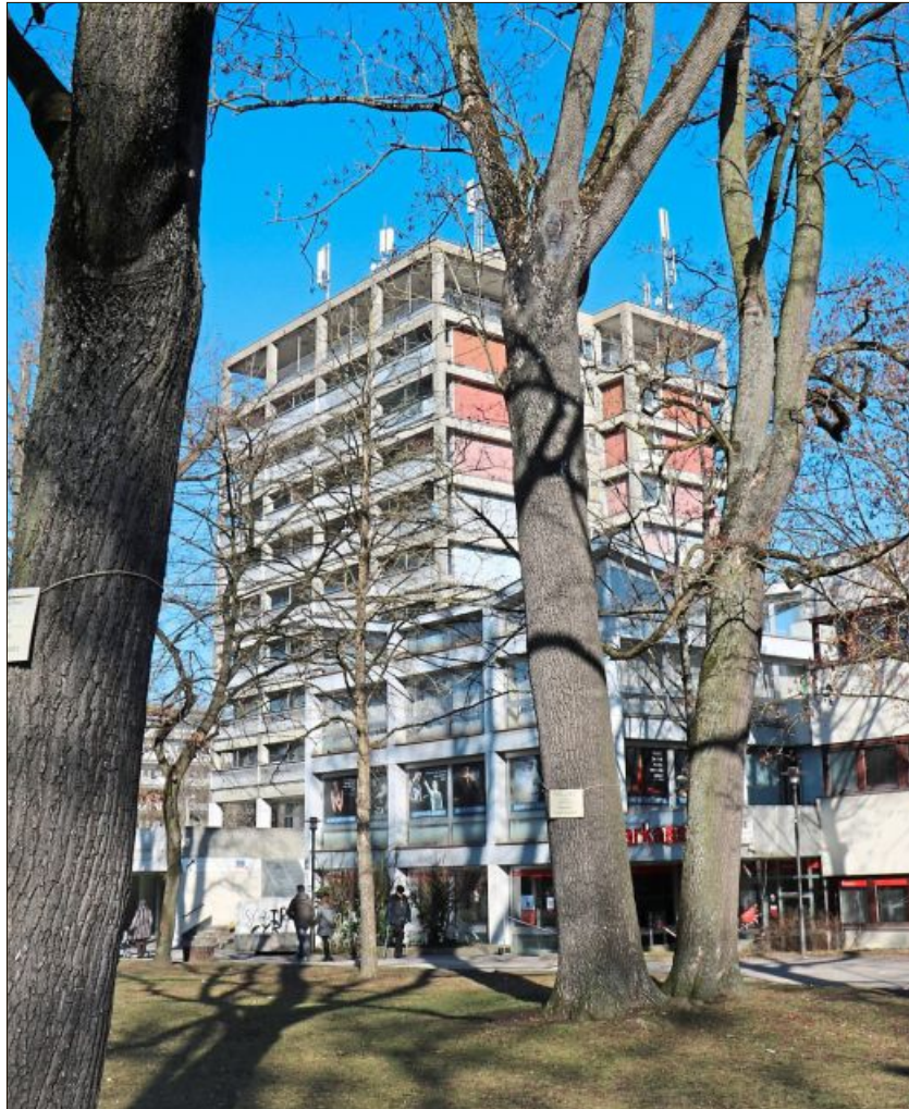
Wie viele Bäume von Abriss und Neubau betroffen sind, weiß man noch nicht.
